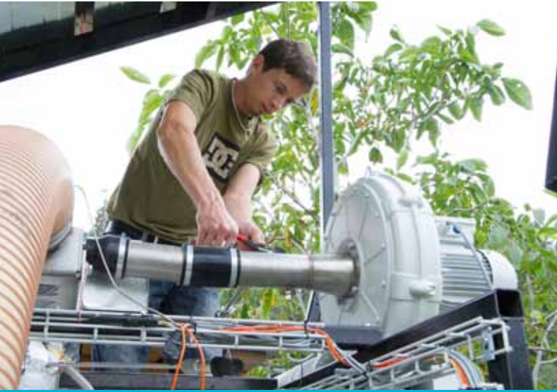
Mario Vögeli bei der Inbetriebnahme einer Schwachgasfackel
