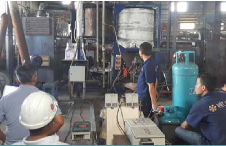
Die fertige Pyrolyse-Anlage in der Viet Hien-Kooperative in Vietnam
