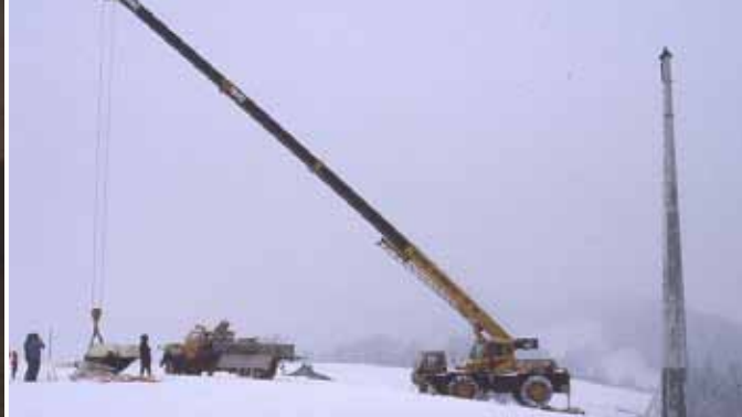
Kleine Zeitreise: Aufstellen des Turms und Inbetriebnahme 1986
